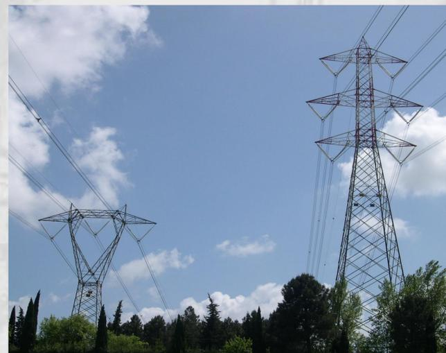
A sinistra il sostegno "a delta" della linea n. 314; a destra il sostegno delle linee in doppia terna con la n. 327 a sinistra e la n. 326 a destra
